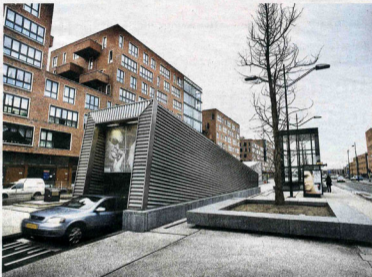
De bekroonde parkeergarage P23 bij het Anton de Komplein.
