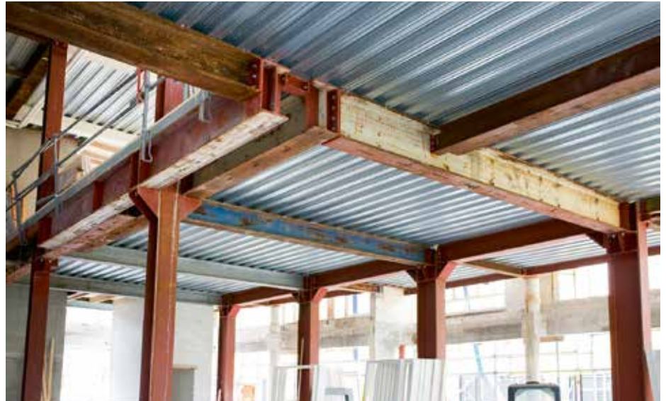
Samengestelde vorkconstructie.
